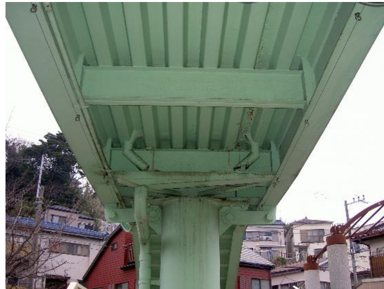
ワイヤー設置完了
